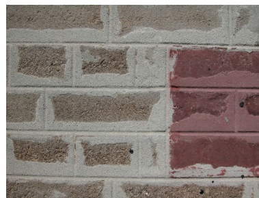
Détail de la mise en oeuvre de la façade. Phot. Elisabeth Justome IVR22_20058002877NUCA
