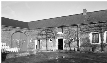
Laiterie, entre le logis et la grange. Phot. Thierry Lefébure IVR22_19960200937X
