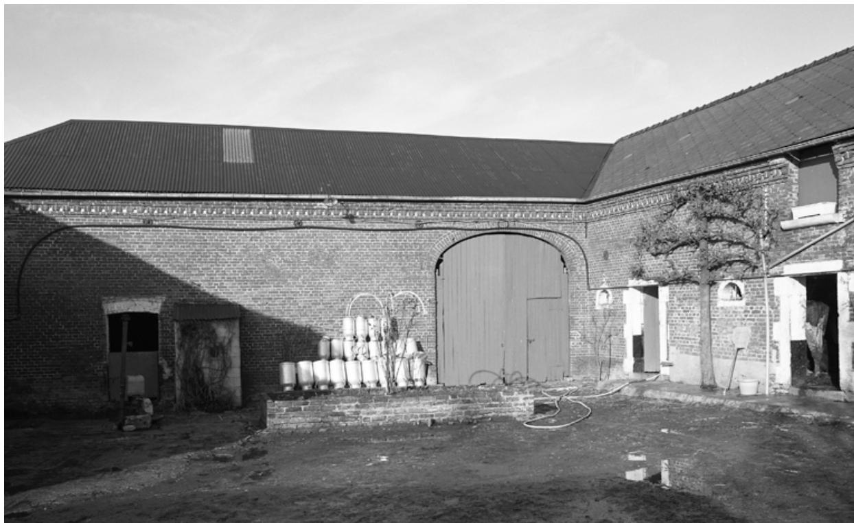
Bâtiment en fond de cour à usage de grange et étable.
