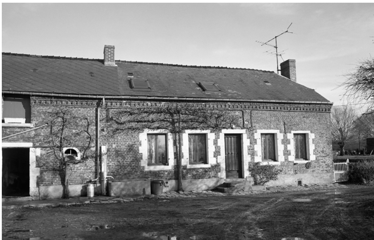
Façade du logis.
