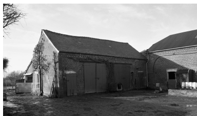
Bâtiment sud-ouest, abritant l'étable à chevaux et la remise. Phot. Thierry Lefébure IVR22_19960200934X
