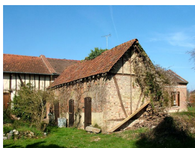
Ancienne étable. Phot. Frédéric Fournis IVR22_20118001133NUCA
