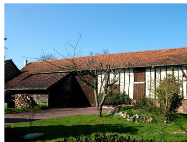
Ancienne grange. Phot. Frédéric Fournis IVR22_20118001135NUCA
