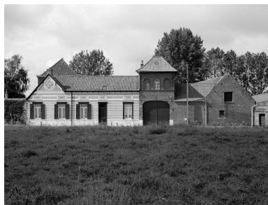
Vue générale de la façade sur rue. Phot. Philippe Dapvril IVR31_20045900431X
