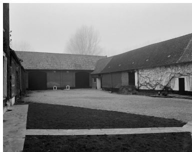
Grange, étables, écuries et porcherie, façades sur cour. Phot. Philippe Dapvril IVR31_20055900011X
