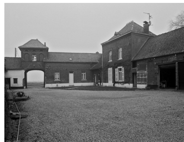
Vue des deux logis, façades sur cour. Phot. Philippe Dapvril IVR31_20055900010X
