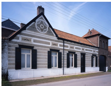
Vue générale de la façade en gravier roulé sur rue. Phot. Pierre Thibaut IVR31_20095901349VA
