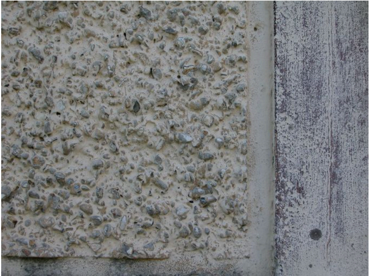
Détail du mur de la maison L'Espérance avec un mélange de petits galets (109 rue Molière).
