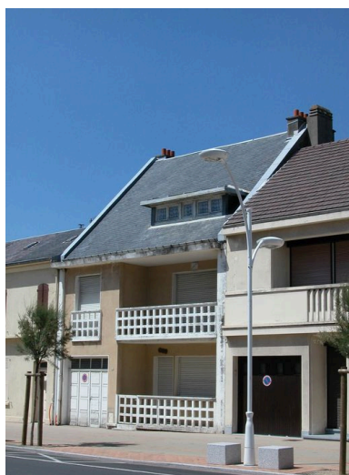
Loggia de la maison dite La Rafale (448 avenue de la Plage). Phot. Elisabeth Justome IVR22_20058004059NUCA
