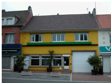
Immeuble peint de couleur jaune (1175 avenue de la Plage). Phot. Elisabeth Justome IVR22_20058003578NUCA
