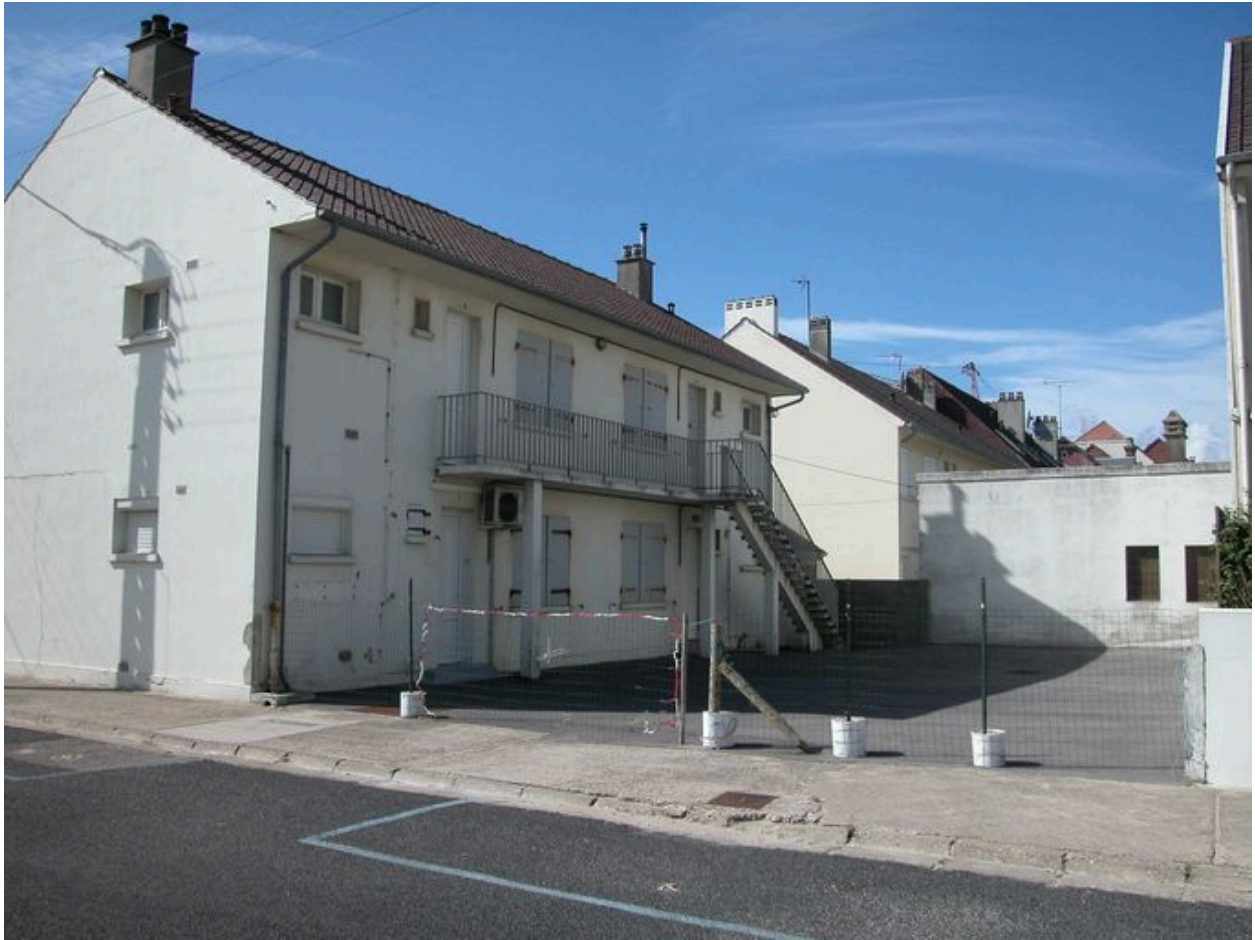
Façade postérieure d'une maison à plusieurs logements accolés et superposés (La Sablière, rue Balzac).
