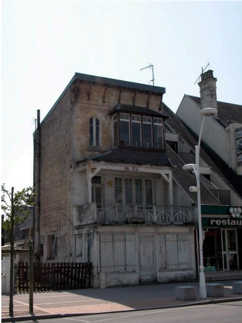
Toit à un pan (Ma Hutte, 671 avenue de la Plage).
