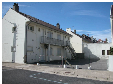
Façade postérieure d'une maison à plusieurs logements accolés et superposés (La Sablière, rue Balzac). Phot. Elisabeth Justome IVR22_20058003808NUCA
