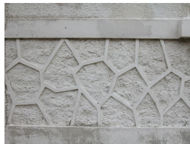
Détail de l'enduit imitant des moellons de pierre (L'Emeraude, 59 Bd Intérieur). Phot. Elisabeth Justome IVR22_20048001458NUCA
