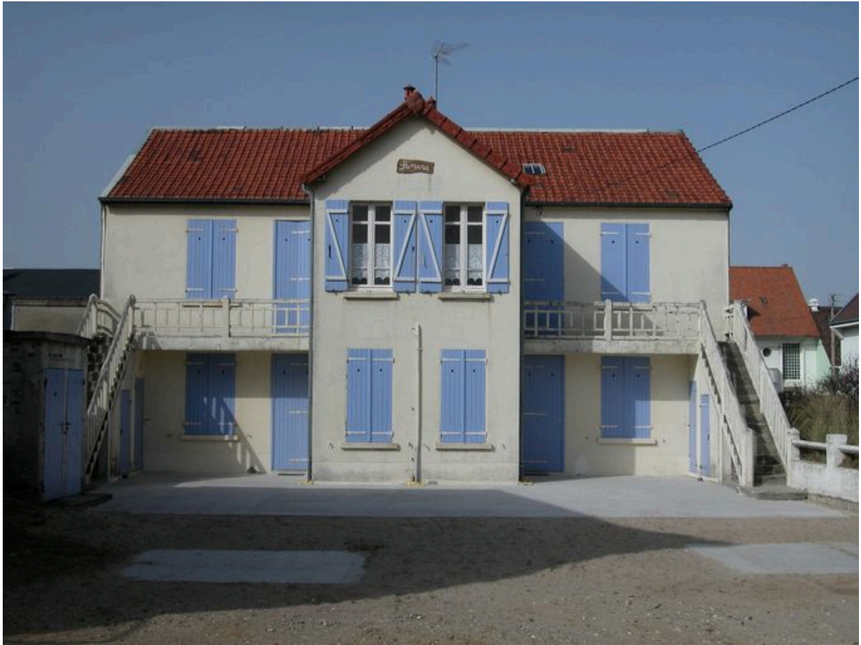
Maison à plusieurs logements accolés et superposés (Samara, 150 rue de la Paix).
