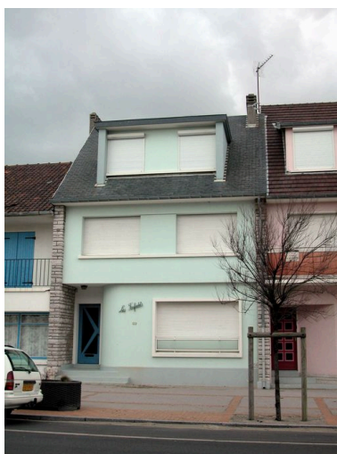
Porche d'entrée dans-oeuvre (Les Farfadets, 1040 avenue de la Plage). Phot. Elisabeth Justome IVR22_20048001463NUCA
