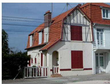
Le gros-oeuvre recouvert d'un enduit peint de couleur blanche (Les Clématites, 360 avenue de la Plage). Phot. Elisabeth Justome IVR22_20058002975NUCA
