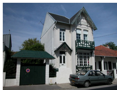
Toiture animée par une noue formant pignon à ferme débordante en façade (Berthe et Lydie, 29 rue des Garennes). Phot. Elisabeth Justome IVR22_20058002925NUCA
