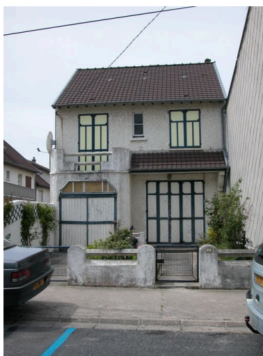
Clôture avec garde-corps carrés (44 rue des Dunes). Phot. Elisabeth Justome IVR22_20058002939NUCA
