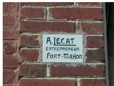
Signature de l'entrepreneur A. Lecat, portée sur une façade. Phot. Elisabeth Justome IVR22_20048001526NUCA
