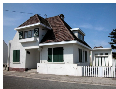
La Gaillarde et son garage isolé en fond de parcelle (38 rue de la Fontaine). Phot. Elisabeth Justome IVR22_20058002810NUCA
