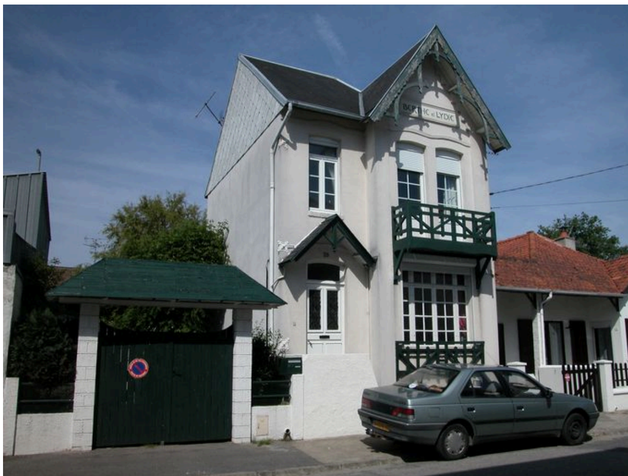
Toiture animée par une noue formant pignon à ferme débordante en façade (Berthe et Lydie, 29 rue des Garennes).
