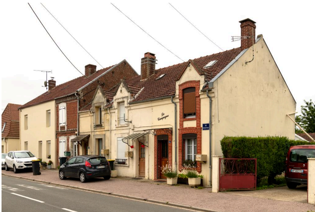
Anciens logements des ouvriers de l'usine Lecomte, n°4-10 rue Principale, vue depuis le nord-est.
