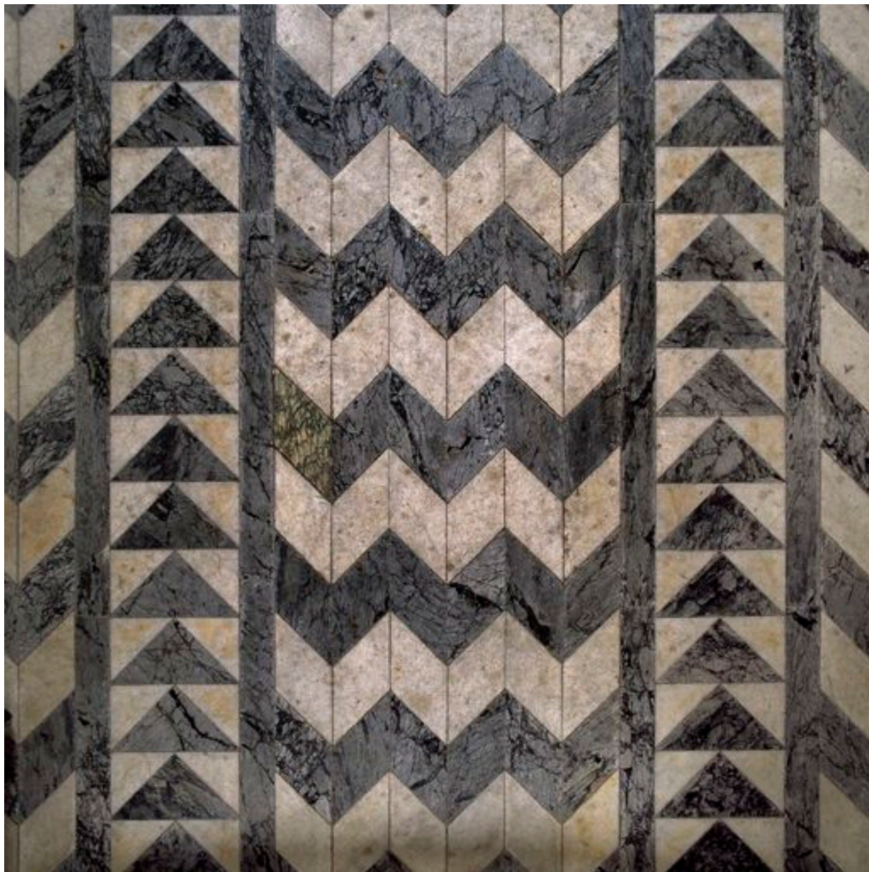
Détail du dallage de la chapelle axiale.
