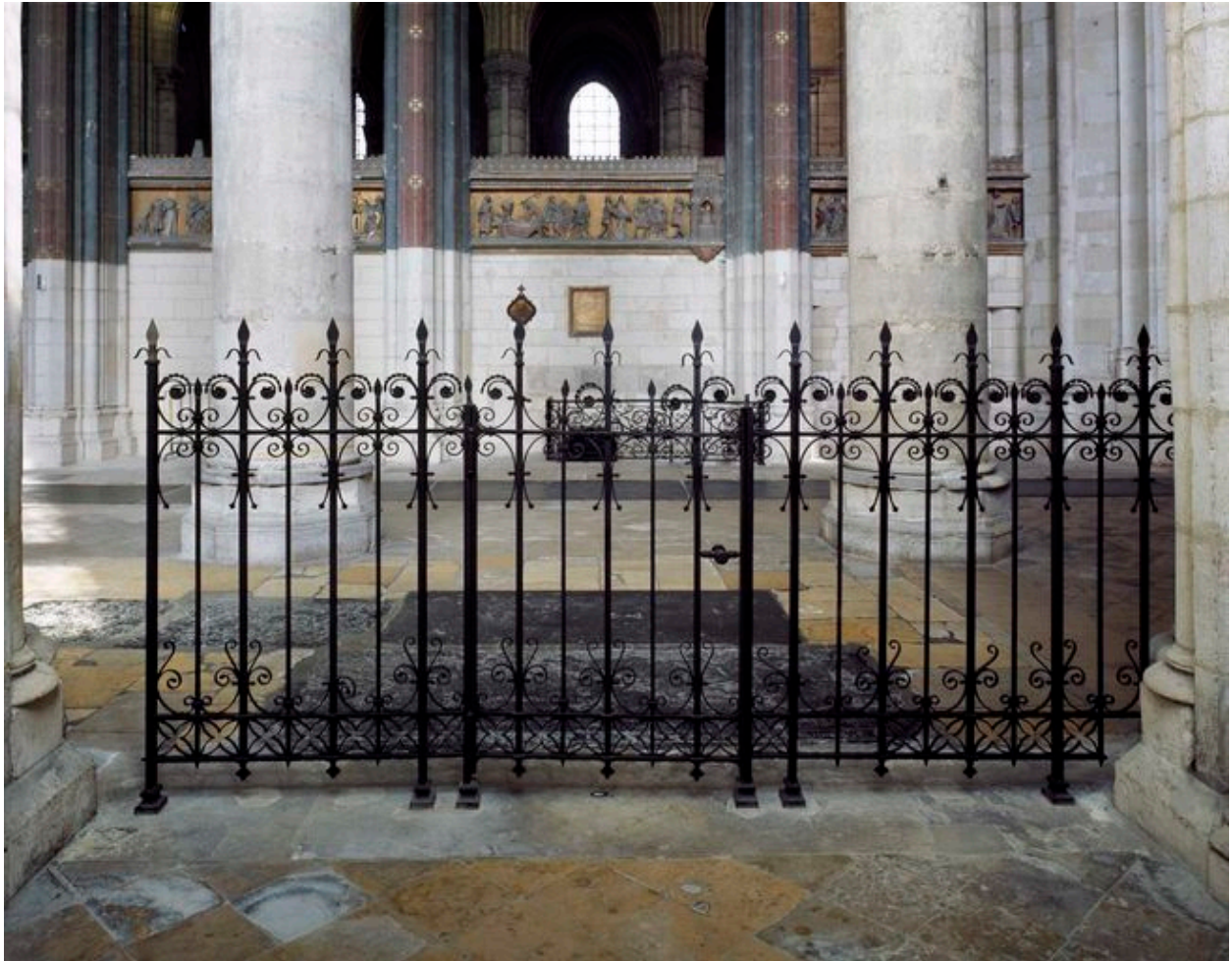
Clôture de chapelle en fer forgé, seconde moitié du 19e siècle.
