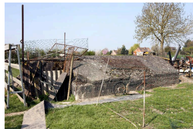
Casemate est, vers l'ouest Phot. Pierre Thibaut IVR31_20155901189NUCA
