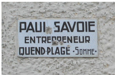
Détail de la plaque portant signature. Phot. Elisabeth Justome IVR22_20058002782NUCA
