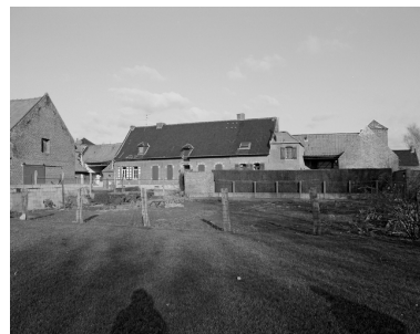
Vue générale de l'élévation postérieure. Phot. Philippe Dapvril IVR31_20055900169X
