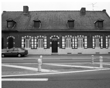
Élévation antérieure du logis. Phot. Philippe Dapvril IVR31_20055900482X
