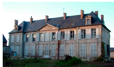
Vue de l'élévation sur le jardin du logis abbatial. Phot. Frédéric Fournis IVR22_20040202663NUC1A
