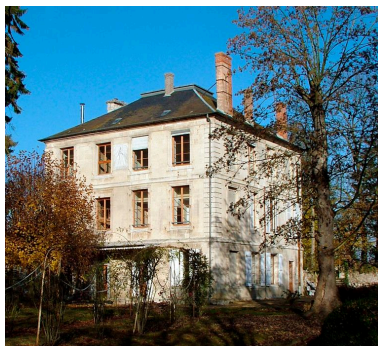
Vue de l'ancienne bibliothèque de l'abbaye, transformée en habitation. Phot. Frédéric Fournis IVR22_20040202640NUC1A
