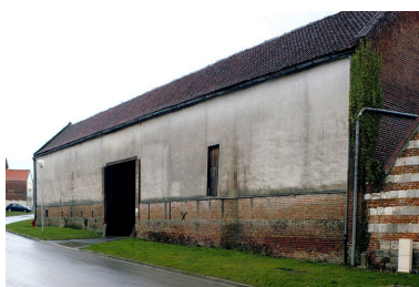
Vue générale depuis la rue. Phot. Thierry Lefébure IVR22_20038001111NUCA
