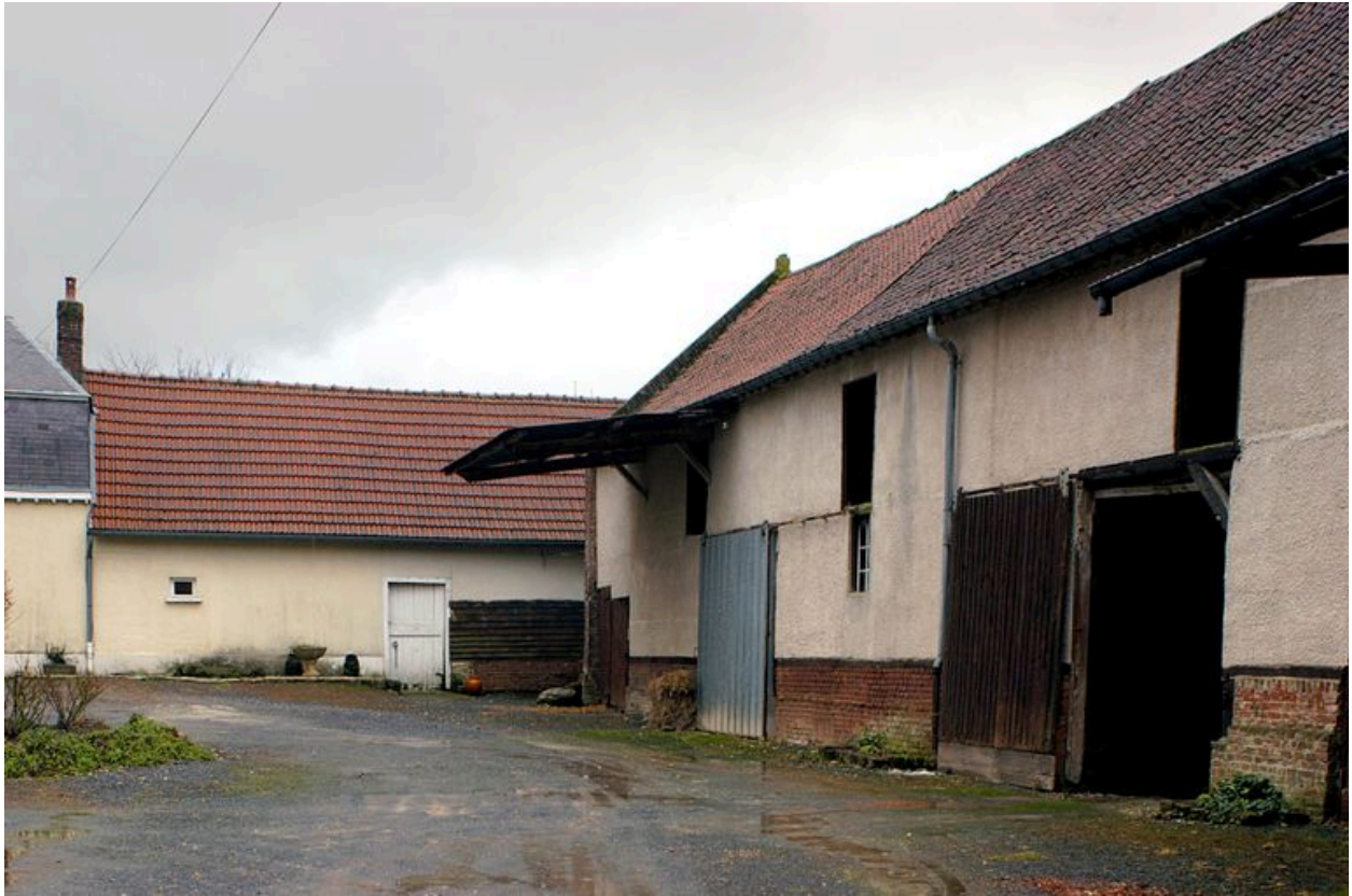
Vue des dépendances, au sud de la cour.
