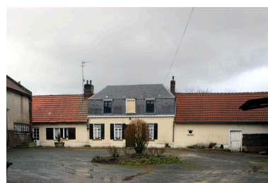
Vue du logis. Phot. Thierry Lefébure IVR22_20038001109NUCA
