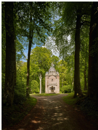
Vue générale de la chapelle dans le bois du Quesnoy depuis le chemin des Rives Phot. Pierre Thibaut IVR22_20226200153NUCA
