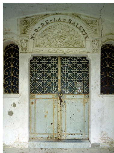
Entrée de la chapelle Notre-Dame de La Salette. (orientée ouest) Phot. Pierre Thibaut IVR22_20226200130NUCA
