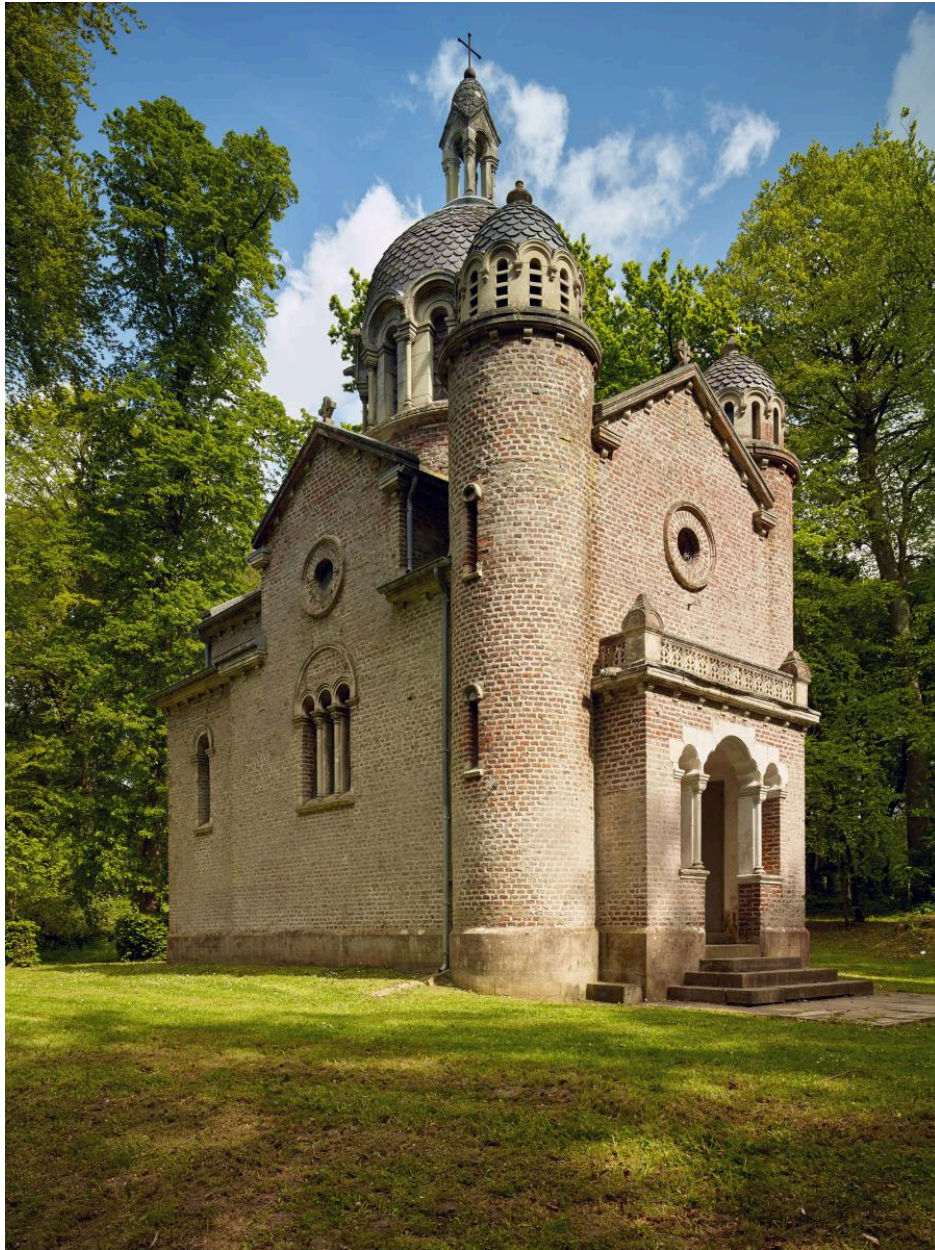
Vue générale de la chapelle Notre-Dame de La Salette depuis le nord-ouest.
