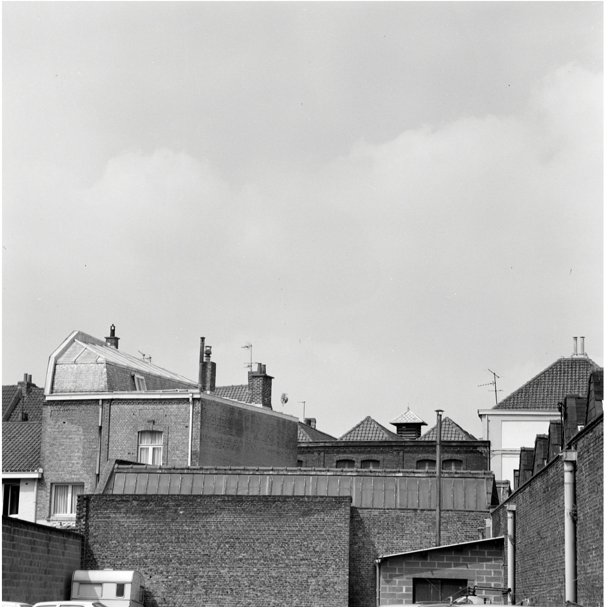
Couvrement de la malterie, vers l'ouest.
