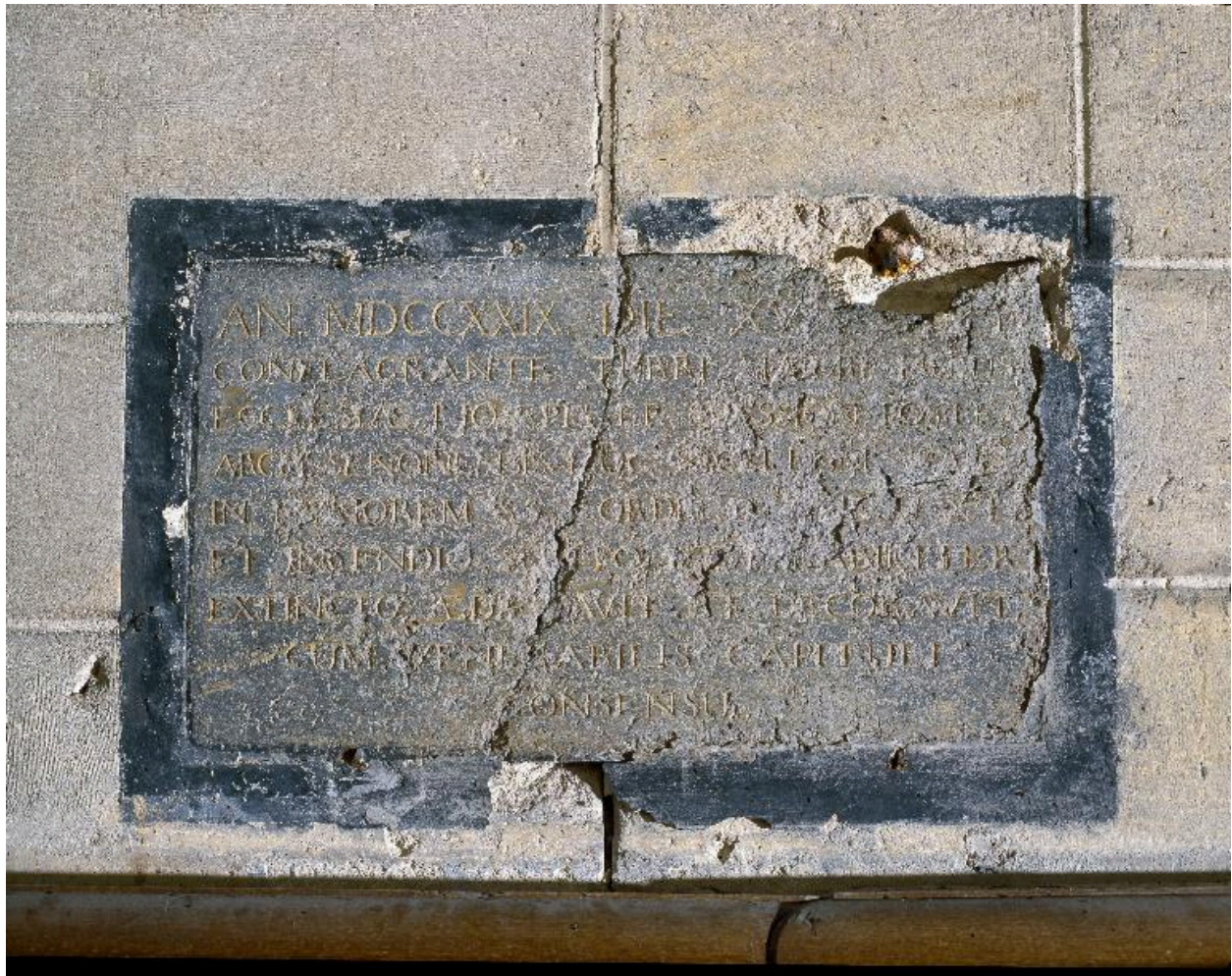
Vue générale de la plaque.
