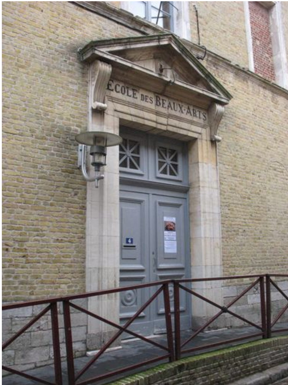
Façade sur rue : portail
