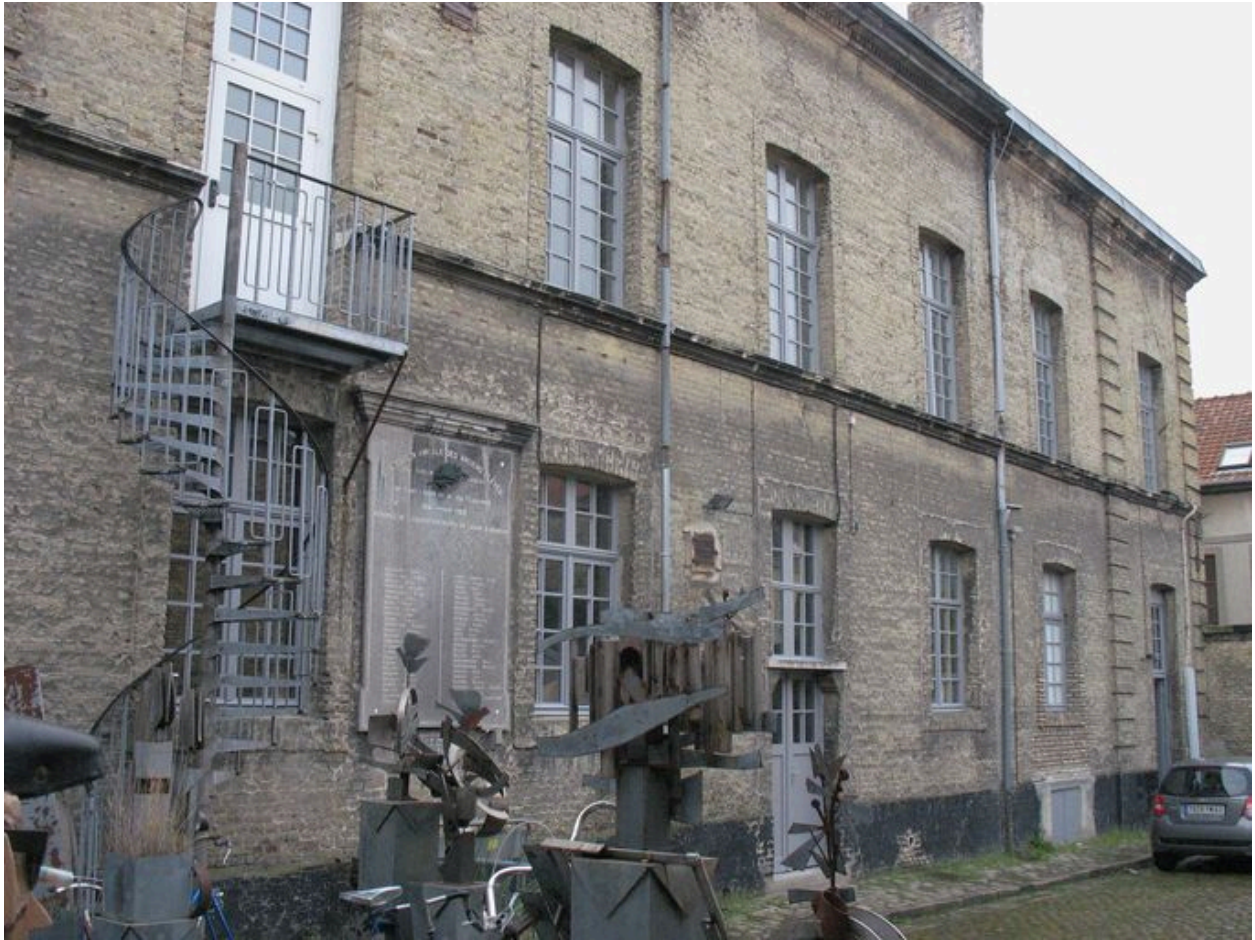
Façade sur cour
