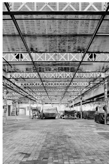
Atelier de fabrication (préparation filature). Intérieur. Phot. Benoît Dufournier IVR22_19888000022Z
