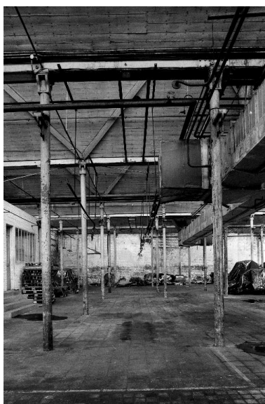
Atelier de préparation de la filature. Vue intérieure. Phot. Benoît Dufournier IVR22_1988800023Z
