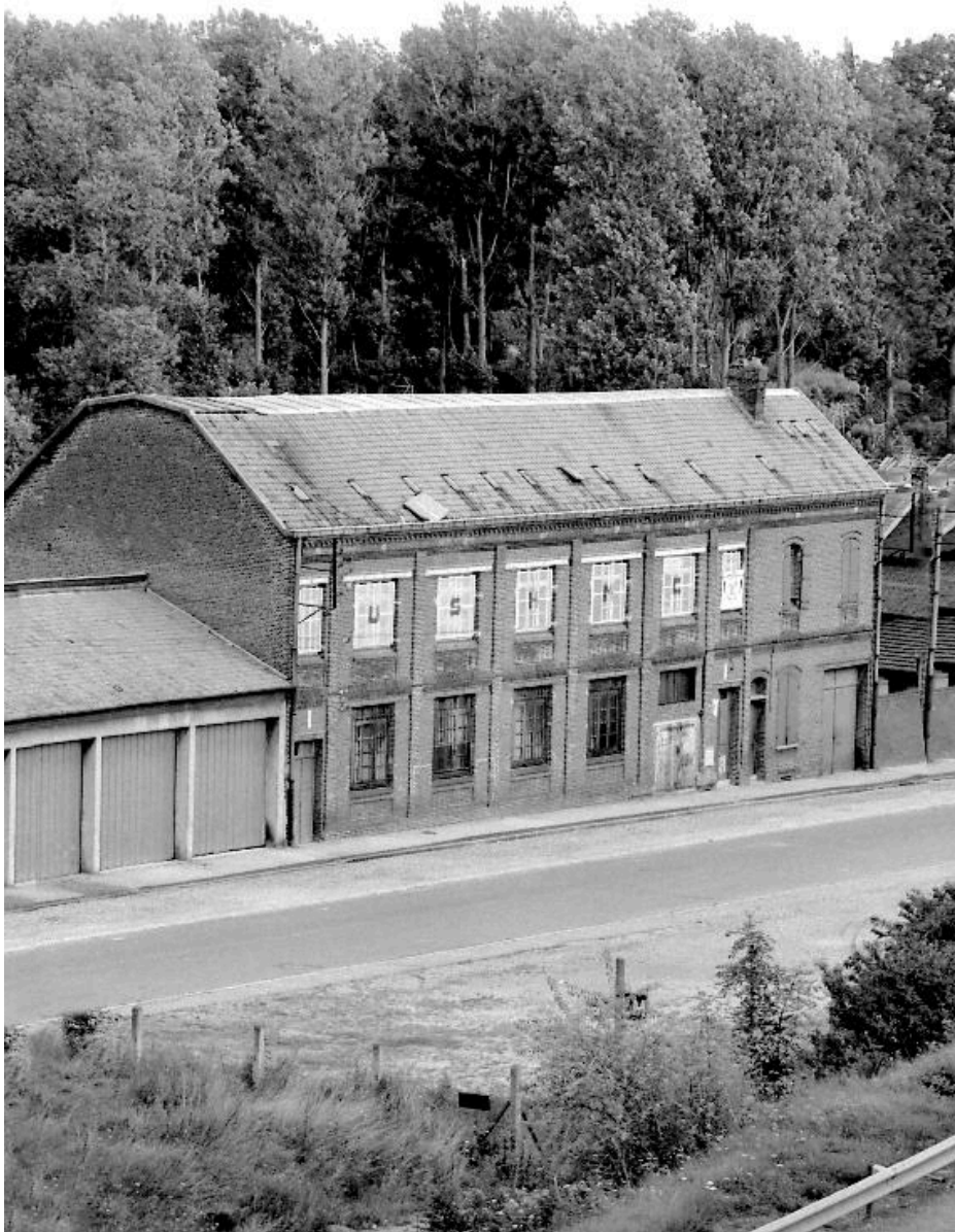
L'ancien laboratoire (?). Vue depuis le sud-ouest.
