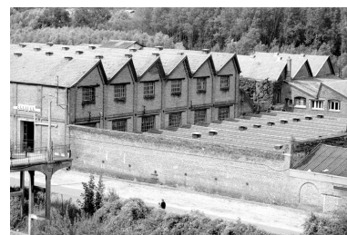
Vue des parties centrales de l'usine Phot. Benoît Dufournier IVR22_19878000125Z
