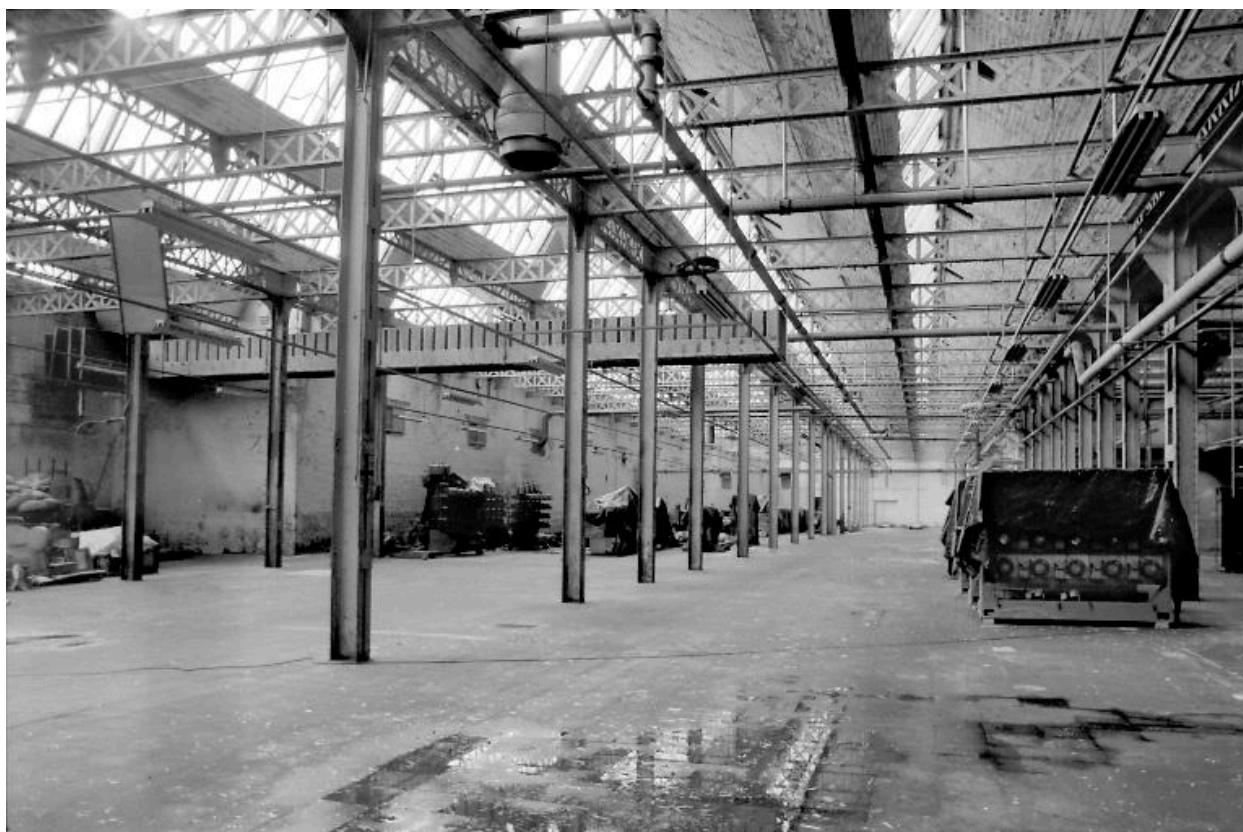
Atelier de fabrication de la corderie, vue intérieure.
