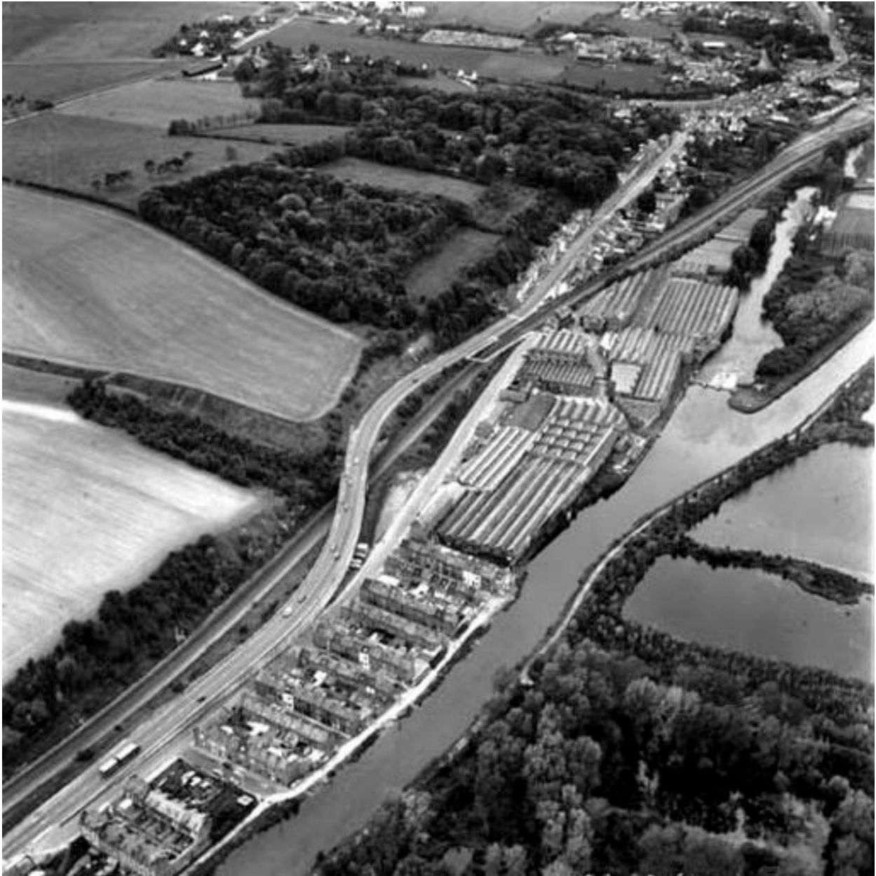
Vue aérienne, flanc sud-ouest.
