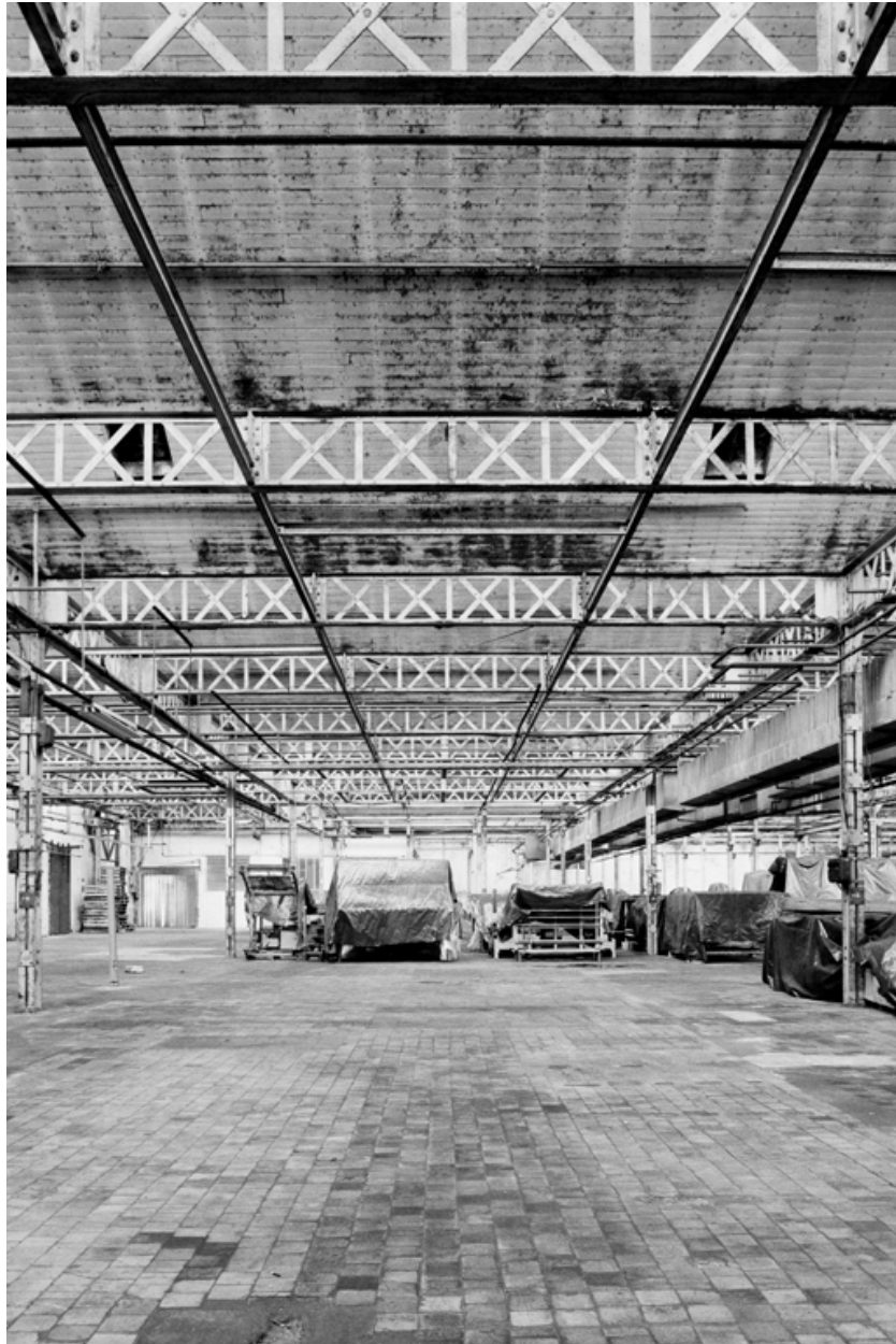
Atelier de fabrication (préparation filature). Intérieur.
