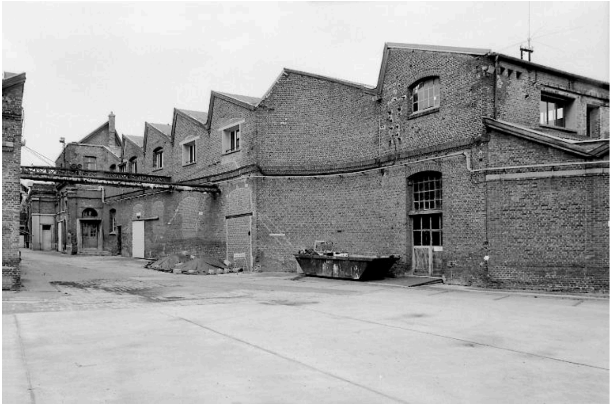
Vue partielle de la partie centrale.
