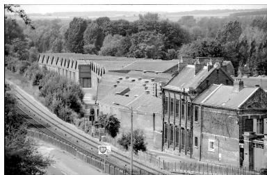
Vue partielle, depuis le sud-est. Phot. Benoît Dufournier IVR22_19878000123Z
