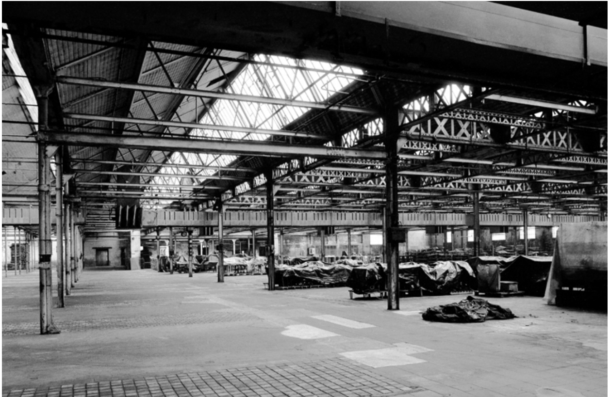
Atelier de fabrication (préparation filature). Intérieur.
