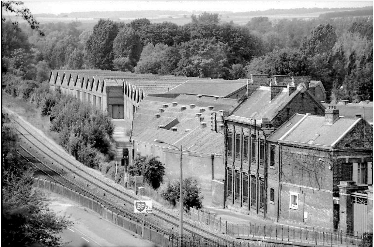
Vue partielle, depuis le sud-est.
