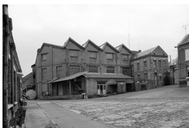
Atelier de fabrication et cantine Phot. Benoît Dufournier IVR22_19888000026Z
