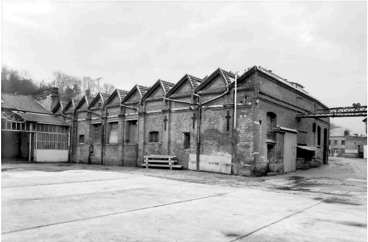
Atelier de réparation mécanique.
