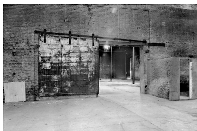
Entrepôt industriel. Vue intérieure. Porte inifugée. Phot. Benoît Dufournier IVR22_19888000100Z
