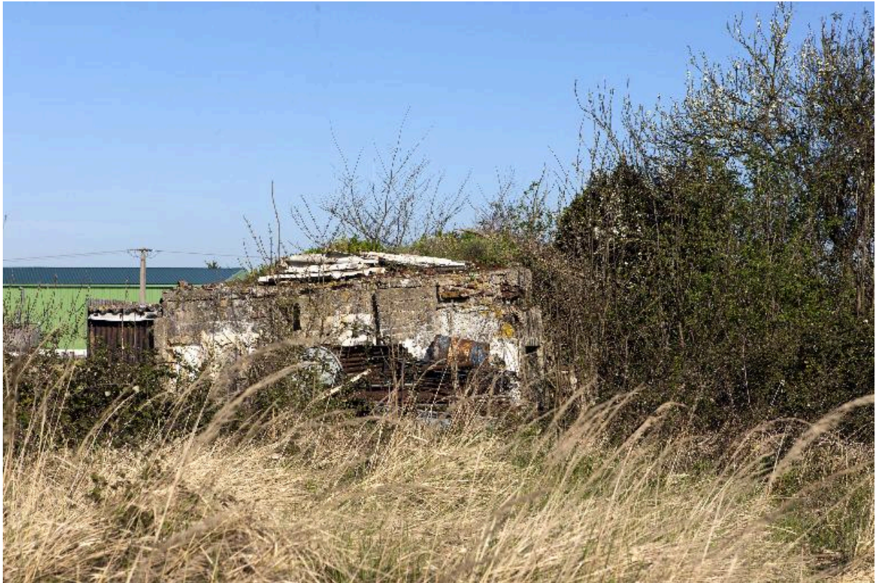
Casemate A, vers le nord
