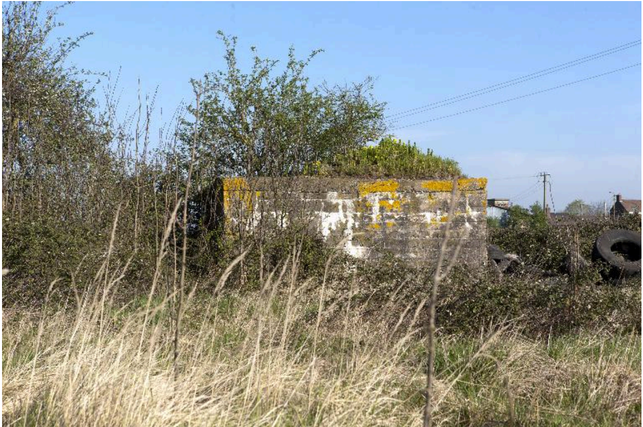
Casemate B, vers le nord
