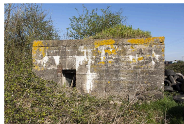
Casemate B, fenêtre sur l'élévation sud Phot. Jean-Marc Ramette IVR31_20145905245NUCA
