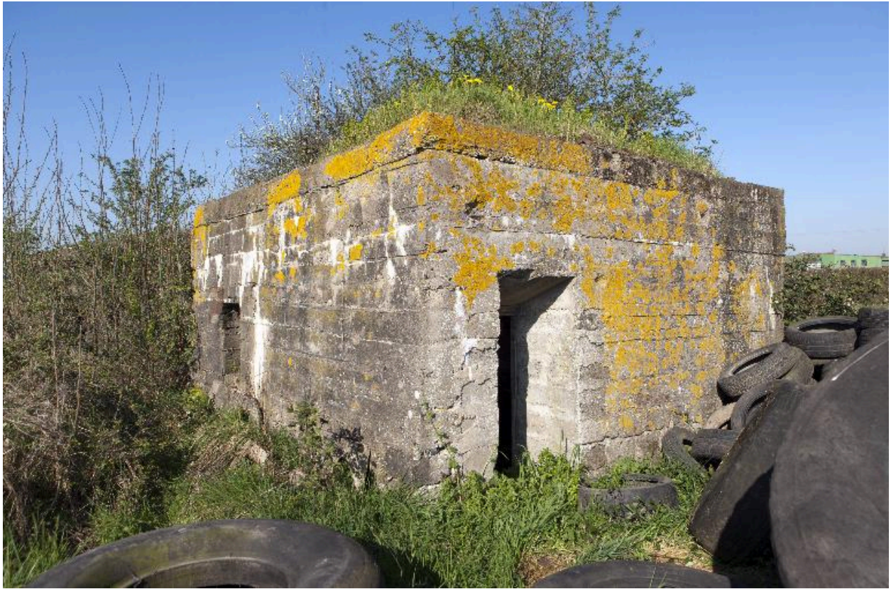
Casemate B, vue de trois-quarts vers l'ouest
