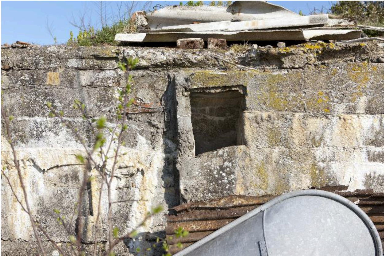
Casemate A. Ouverture sur l'élévation sud
