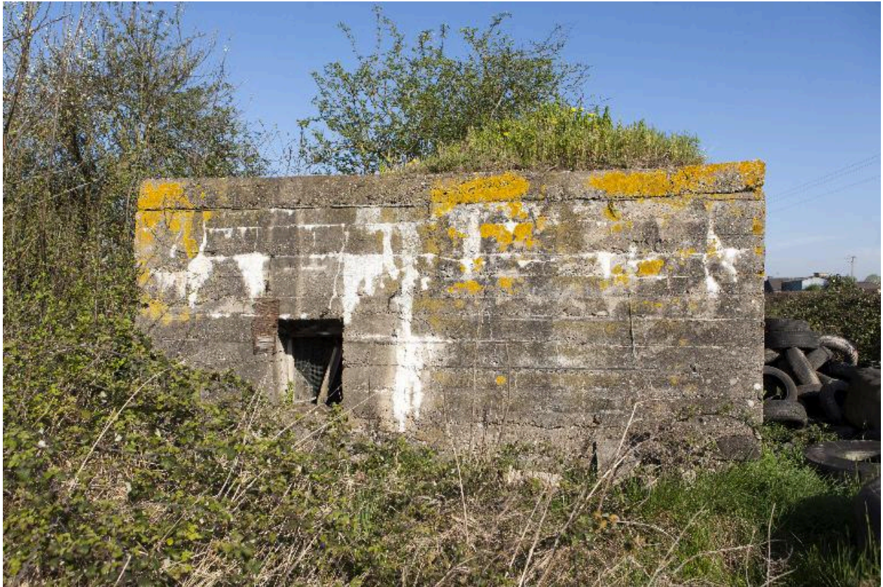
Casemate B, fenêtre sur l'élévation sud
