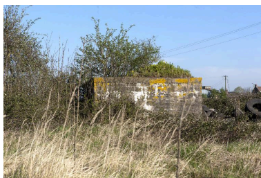
Casemate B, vers le nord Phot. Jean-Marc Ramette IVR31_20145905243NUCA
