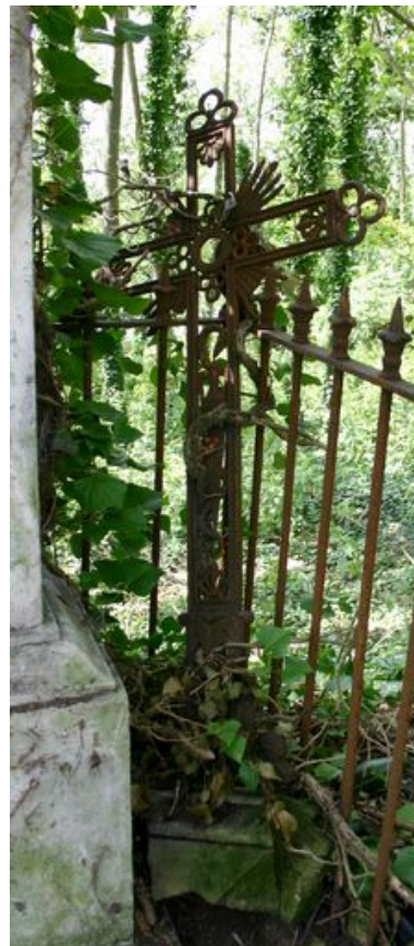
Croix funéraire en fonte et fer forgé, qui surmontait peut-être le fronton de la stèle. Phot. Caroline Vincent IVR22_20078001045NUCA
