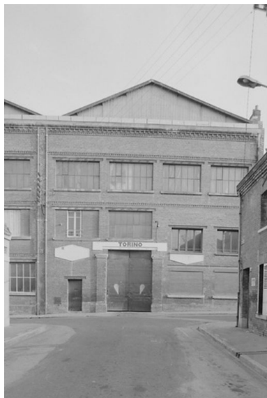
Atelier de fabrication, élévation antérieure. Phot. Thierry Lefébure IVR22_19888000734Z
