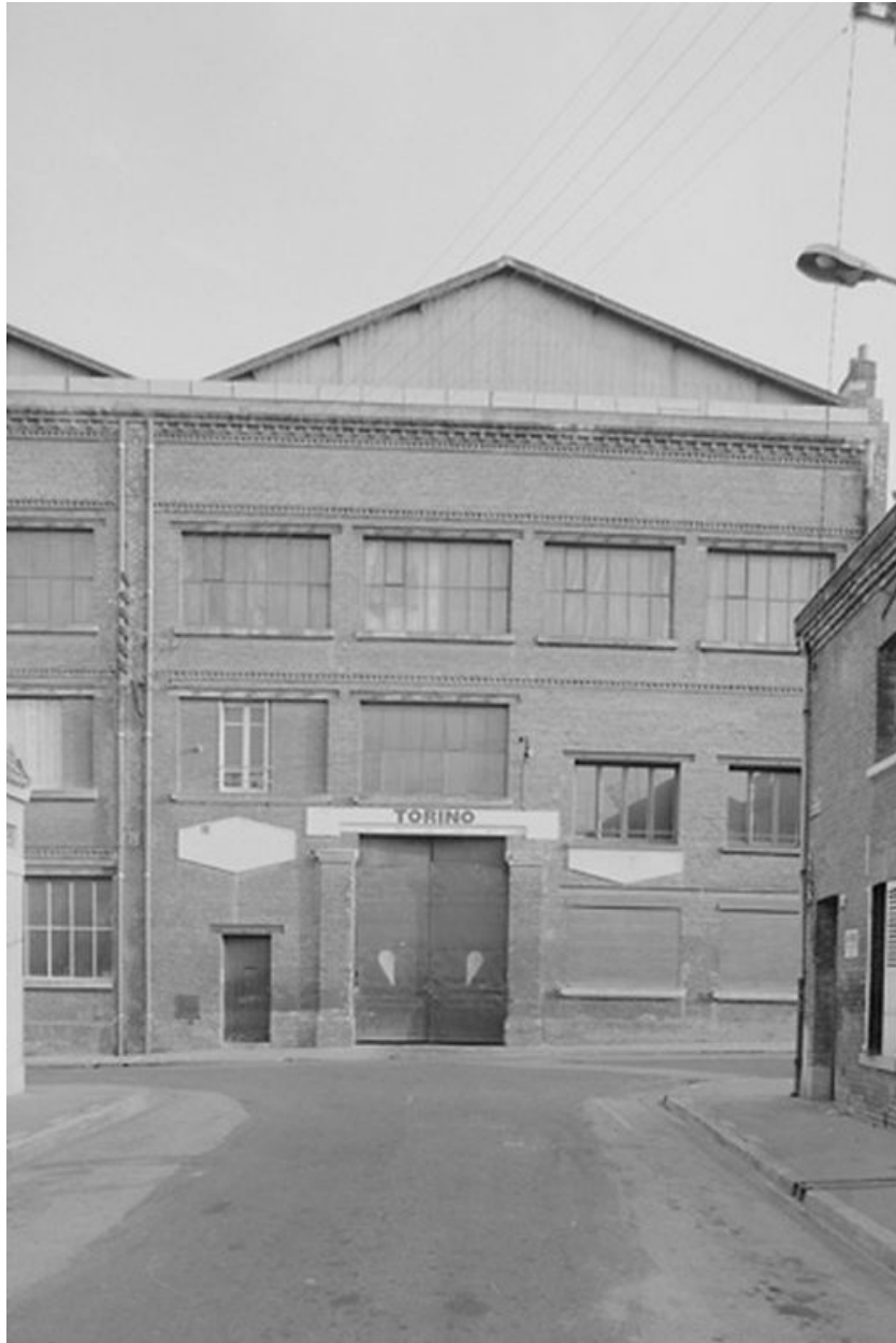
Atelier de fabrication, élévation antérieure.
